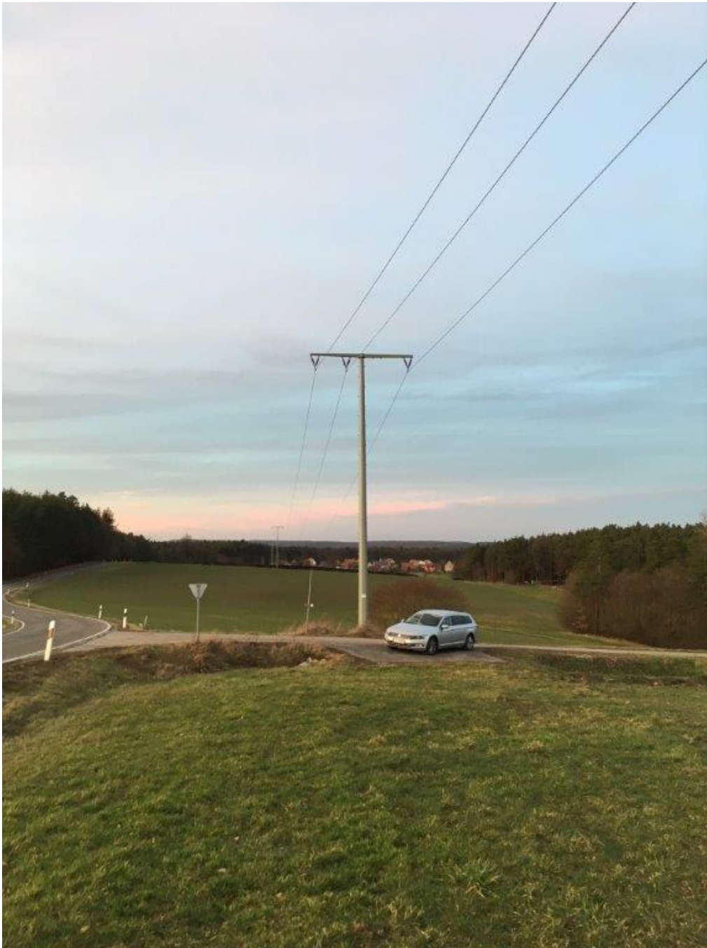
Blick entlang der Kreisstraße und 20 kV Leitung
