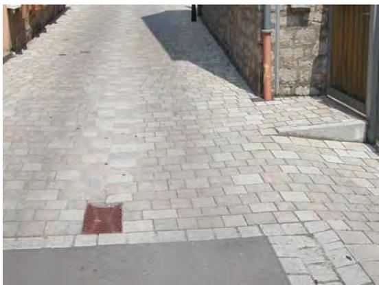
Die Entwässerung wird über eine Mittelrinne erfolgen. Der Rinnenausbau wird direkt als durchgehende Mittelfuge mit den anschließenden Betonpflastersteinen in Sandbeton gesetzt. Daran schließt das Pflaster in Splittbettung an. Damit wird die Rinne nicht als eigenständiges Gestaltelement in Erscheinung treten.
