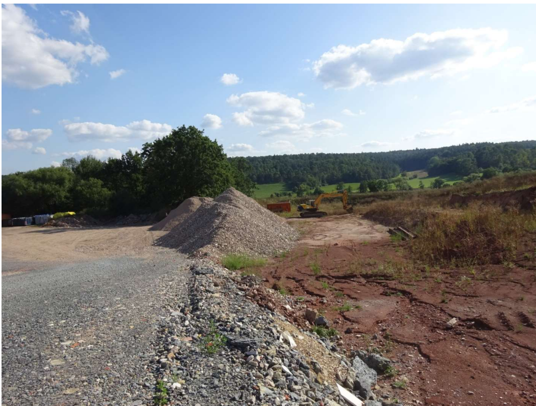
Blick nach Süden, hinter dem Bagger ist der Wall am südlichen Rand erkennbar
